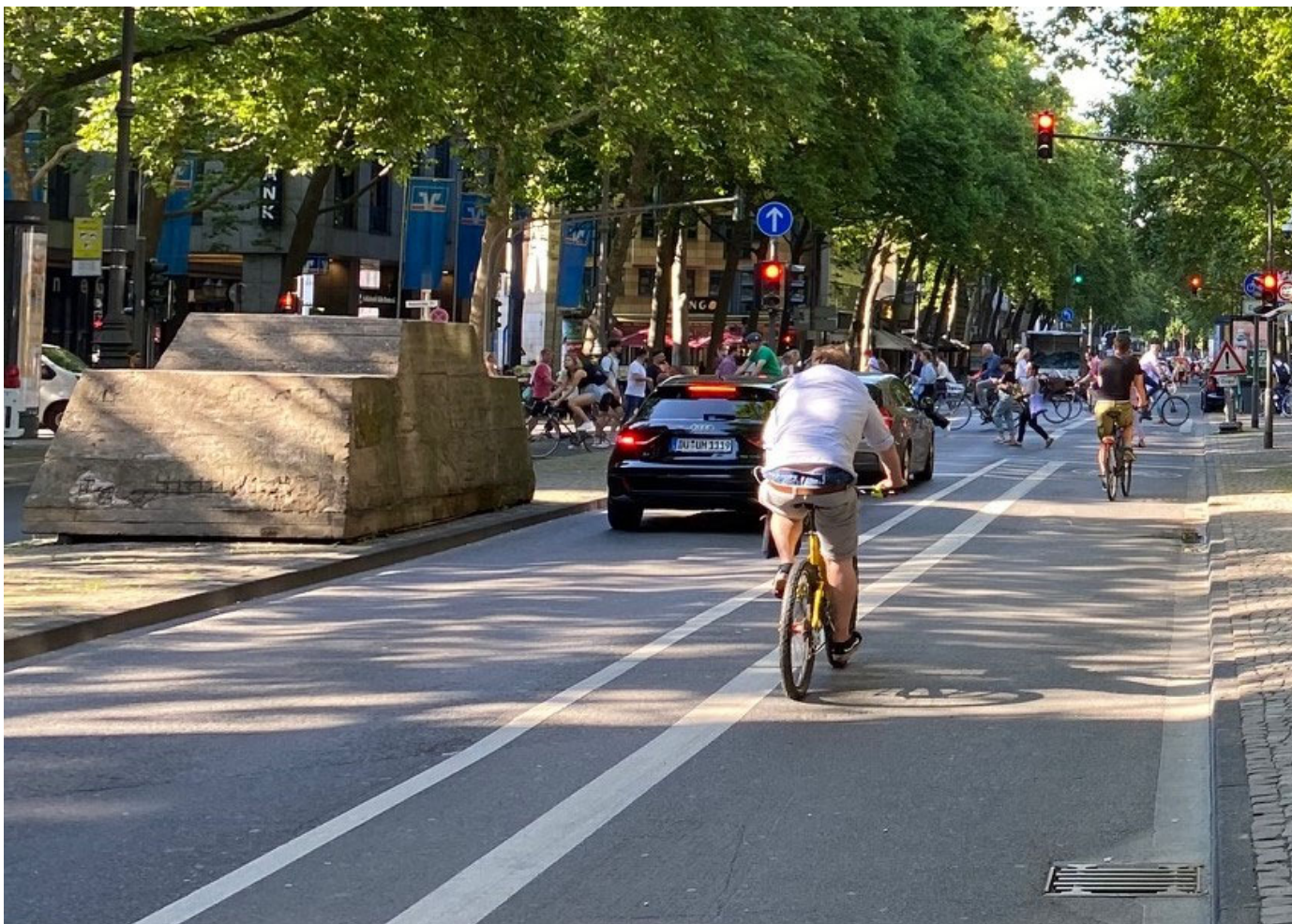
Bilder 48 bis 50 | Quer verlaufende Nebenachse des Radverkehrs: eigene Radverkehrssignalisierung mit kurzen, auf der Außenseite neben den Radfahrstreifen angeordneten Aufstellflächen für den vom Habsburger Ring auf die Achse abbiegenden Radverkehr, oben links in Richtung Maastrichter Straße, oben rechts in Richtung Ehrenstraße betrachtet; im unteren Bild sind an dieser Stelle bei Grün Querende zu Fuß und mit dem Rad aus der Perspektive des Hohenzollernrings zu erkennen
