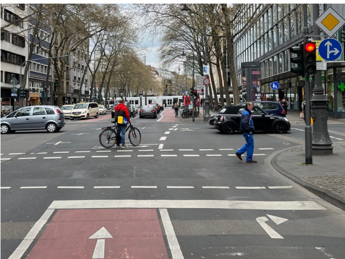
Bilder 31 und 32 | Radverkehrsführung in Knotenpunkten: markierte Aufstellfläche in Kreuzungsmitte für aus der Seitenstraße linksabbiegende Radfahrende (linkes Bild); langgezogener und rot eingefärbter Radfahrstreifen im Verflechtungsbereich zweier dicht aufeinander folgender Signalanlagen
