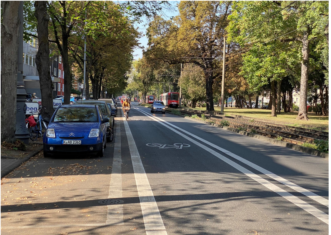
Bild 1 | Abschnitt des Innenstadtrings nach der Umgestaltung: Umnutzung der äußeren Fahrstreifen der ursprünglich zweistreifigen Richtungsfahrbahn zu einem 2,50 m breiten Radfahrstreifen mit beidseitigen Sicherheitstrennstreifen zum Längsparkstreifen und zum verbleibenden Kfz-Fahrstreifen in Form einer doppelten Breitstrichmarkierung sowie überdimensionierten Fahrradpiktogrammen auf der Fahrbahn
