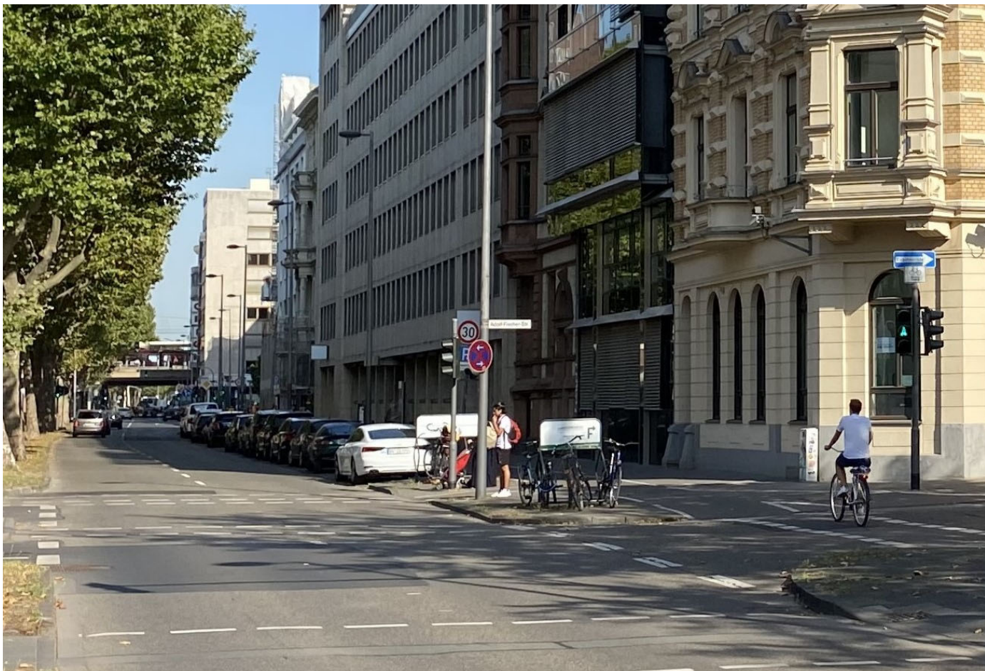
Bild 14 | Unterstützende Maßnahme Tempo 30: Anordnung einer Geschwindigkeitsbeschränkung auf 30 km/h auf dem gesamten Ringstraßenzug, verbunden mit der Aufhebung der Radwegebenutzungspflicht im Seitenraum, abgeschlossen bis Ende August 2019
