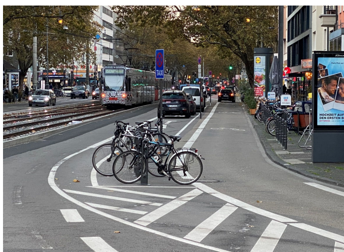
Bilder 42 bis 44 | Sonderlösung im Querschnitt: ausgehend von der Knotenpunktausfahrt sind Taxis, Fahrradparken und Liefer/Laden in Fahrbahnmitte angeordnet, vormalige Längsparkstände am Fahrbahnrand wurden mit Bügeln zum Abstellen von Fahrrädern ausgestattet oder für außergastronomische Nutzungen freigegeben; aus der Sperrfläche wird im weiteren Straßenverlauf ein Schutzstreifen für geradeaus Radfahrende entwickelt (Bild unten rechts im Hintergrund)
