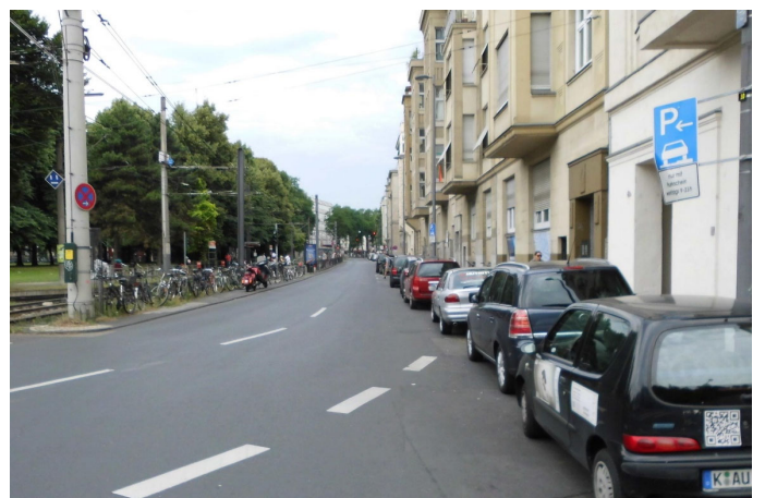
Bilder 6 bis 11 | Vorher-Situation: überwiegend zweistreifige Richtungsfahrbahnen für den Kfz-Verkehr, in Knotenpunkten teilweise durch signalisierte Abbiegefahrstreifen und frei fließende Rechtsabbiegestreifen (Mitte rechts) erweitert; Radverkehrsführung auf rd. 1 m schmalen Radwegen aus rotem Klinker lediglich auf einem zentralen Ringabschnitt (Fotos ganz oben), darüber hinaus keine oder deutlich zu schmale (unten links) Radverkehrsanlagen, in Teilabschnitten „Radfahrer frei“ auf den Gehwegen oder auch erlaubte Mitnutzung des ohnehin schmalen Gehwegs durch parkende Kraftfahrzeuge (unten rechts)
