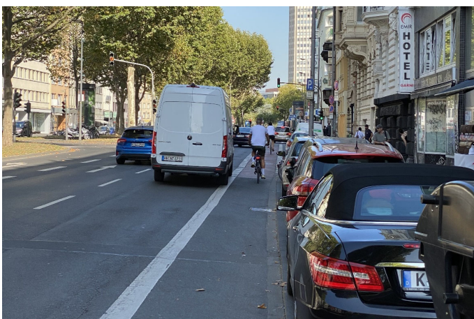
Bilder 6 bis 11 | Vorher-Situation: überwiegend zweistreifige Richtungsfahrbahnen für den Kfz-Verkehr, in Knotenpunkten teilweise durch signalisierte Abbiegefahrstreifen und frei fließende Rechtsabbiegestreifen (Mitte rechts) erweitert; Radverkehrsführung auf rd. 1 m schmalen Radwegen aus rotem Klinker lediglich auf einem zentralen Ringabschnitt (Fotos ganz oben), darüber hinaus keine oder deutlich zu schmale (unten links) Radverkehrsanlagen, in Teilabschnitten „Radfahrer frei“ auf den Gehwegen oder auch erlaubte Mitnutzung des ohnehin schmalen Gehwegs durch parkende Kraftfahrzeuge (unten rechts)
