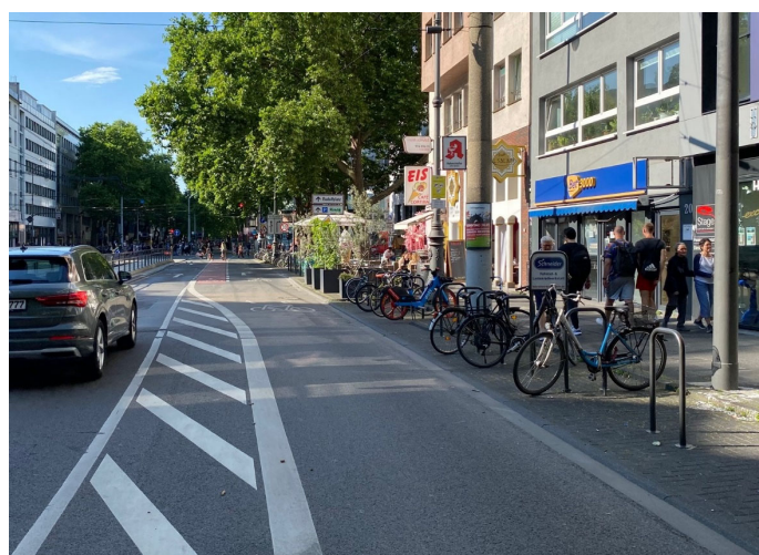
Bilder 42 bis 44 | Sonderlösung im Querschnitt: ausgehend von der Knotenpunktausfahrt sind Taxis, Fahrradparken und Liefer/Laden in Fahrbahnmitte angeordnet, vormalige Längsparkstände am Fahrbahnrand wurden mit Bügeln zum Abstellen von Fahrrädern ausgestattet oder für außergastronomische Nutzungen freigegeben; aus der Sperrfläche wird im weiteren Straßenverlauf ein Schutzstreifen für geradeaus Radfahrende entwickelt (Bild unten rechts im Hintergrund)
