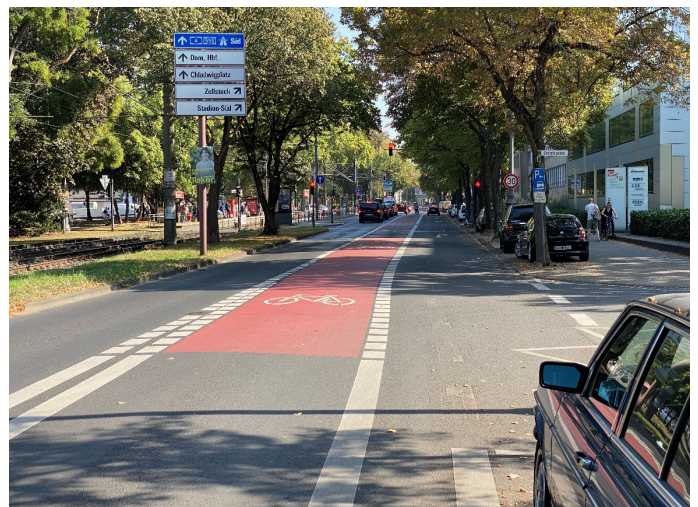
Bilder 31 und 32 | Radverkehrsführung in Knotenpunkten: markierte Aufstellfläche in Kreuzungsmitte für aus der Seitenstraße linksabbiegende Radfahrende (linkes Bild); langgezogener und rot eingefärbter Radfahrstreifen im Verflechtungsbereich zweier dicht aufeinander folgender Signalanlagen
