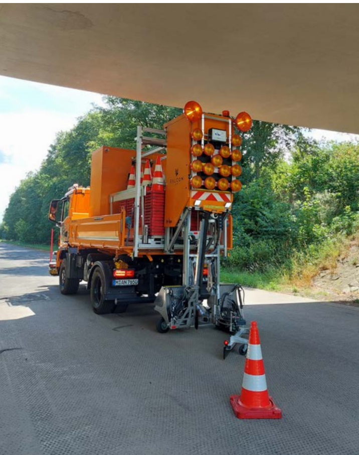
Pylone werden automatisch aufgestellt.
