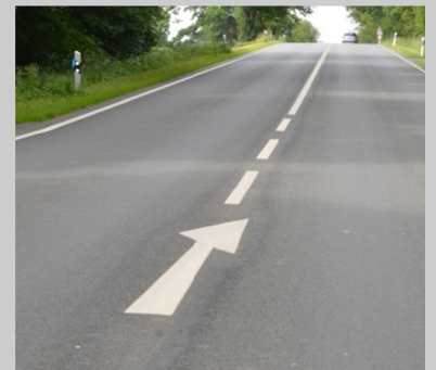
Warnlinien mit Pfeilmarkierung zur Ankündigung von Überholverboten
