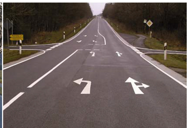
Einrichten eines Linksabbiegestreifens auch bei beengten Platzverhältnissen
