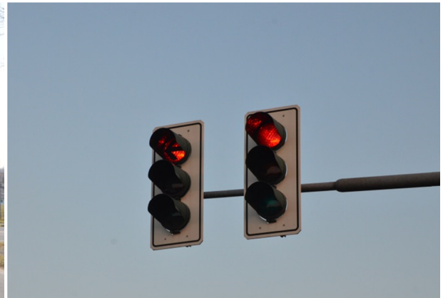
Anbringen von Kontrastblenden zur besseren Erkennbarkeit
