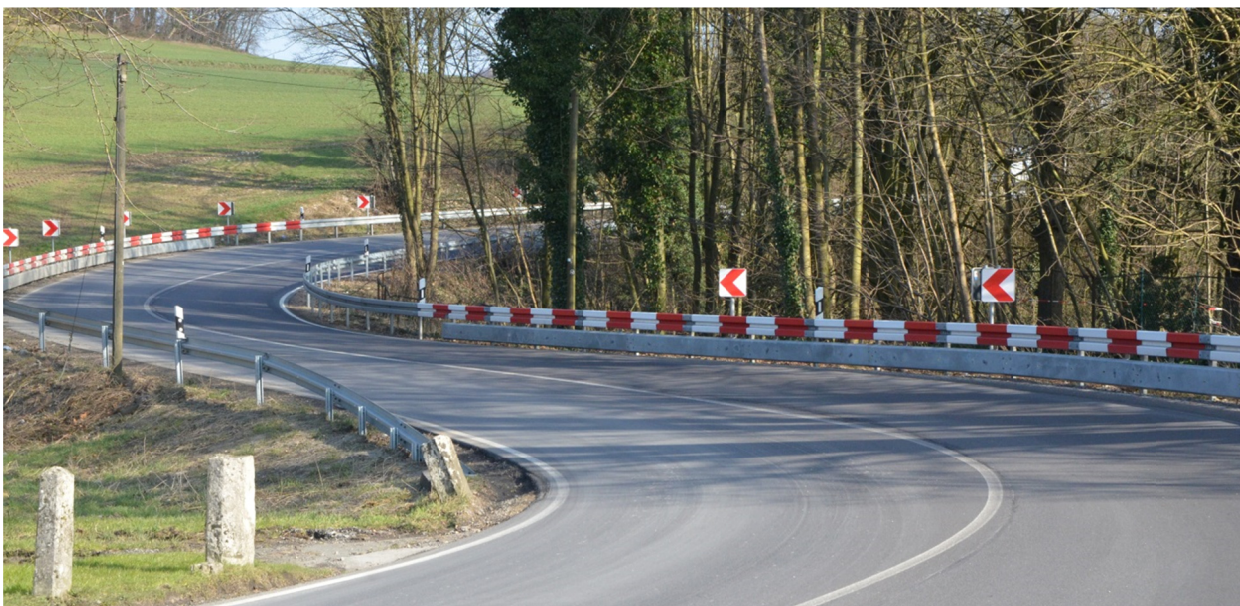
Schutzplanke mit Leitprofil, Unterfahrschutz und aufgelösten Richtungstafeln hinter der Schutzplanke
