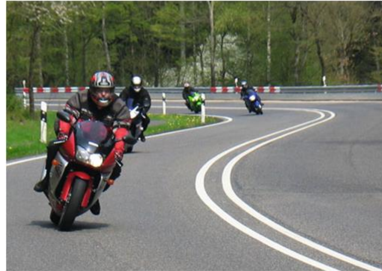
Bild 26: Aufweitung der Fahrstreifenbegrenzung
