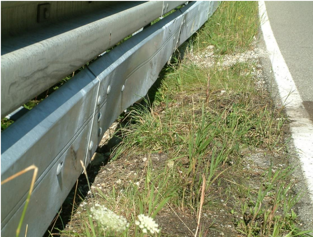
Unterfahrschutz nach einem Anprall eines Motorradfahrers
