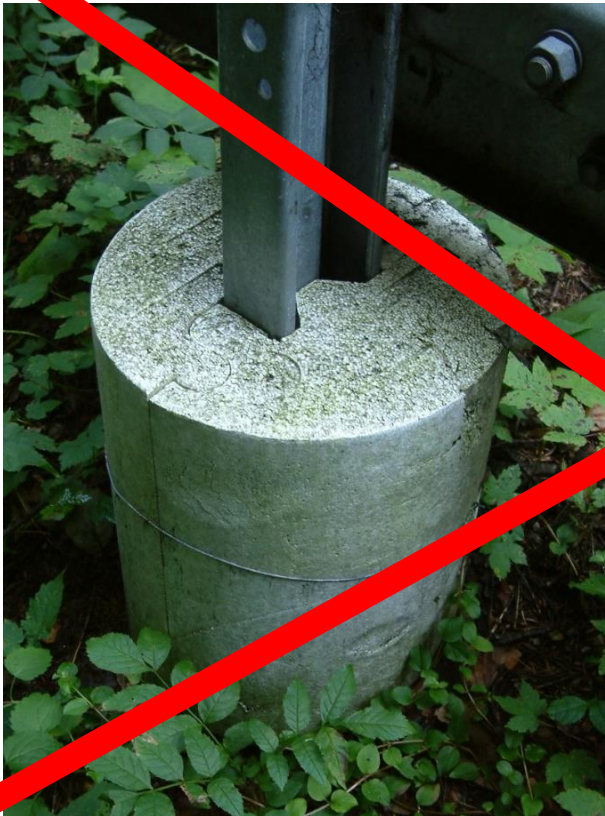
Ummantelung von Schutzplankenposten aus Styropor
