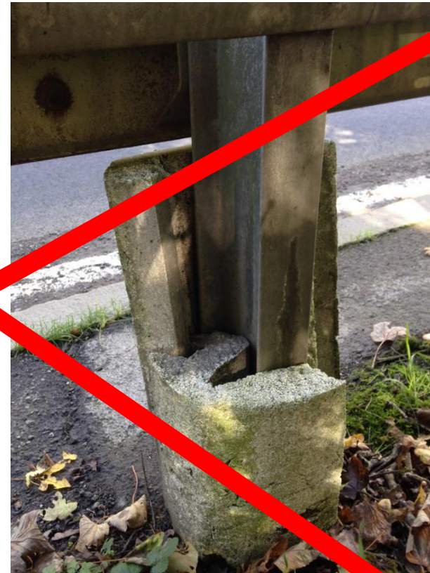
Ummantelung von Schutzplankenposten aus Styropor
