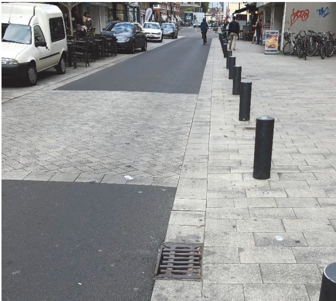
Bilder 31 und 32 | Oberflächenmaterialien: granitgrauweiße Betonsteine in unterschiedlichen Platten- und Steinformaten mit Einfräsung der Noppen- und Rillenstruktur für Bodenindikatoren im Werk sowie anthrazitgraue Betonsteinzeile zur Fassung der Pflasterfläche in den Knotenpunkten mit unterstützender Leitfunktion für Sehbeeinträchtigte
