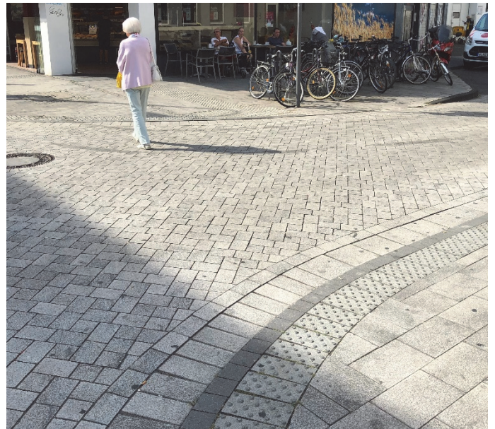
Bilder 31 und 32 | Oberflächenmaterialien: granitgrauweiße Betonsteine in unterschiedlichen Platten- und Steinformaten mit Einfräsung der Noppen- und Rillenstruktur für Bodenindikatoren im Werk sowie anthrazitgraue Betonsteinzeile zur Fassung der Pflasterfläche in den Knotenpunkten mit unterstützender Leitfunktion für Sehbeeinträchtigte
