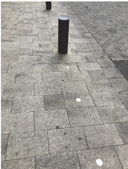
Bilder 33 und 34 | Beleuchtung: Straßenlaternen mit Gelblicht und LED-Lichtelementen im Zuge der östlich der Fahrbahn verlaufenden Pollerreihe, die nachts den linearen Verlauf der römischen Straße betonen sollen
