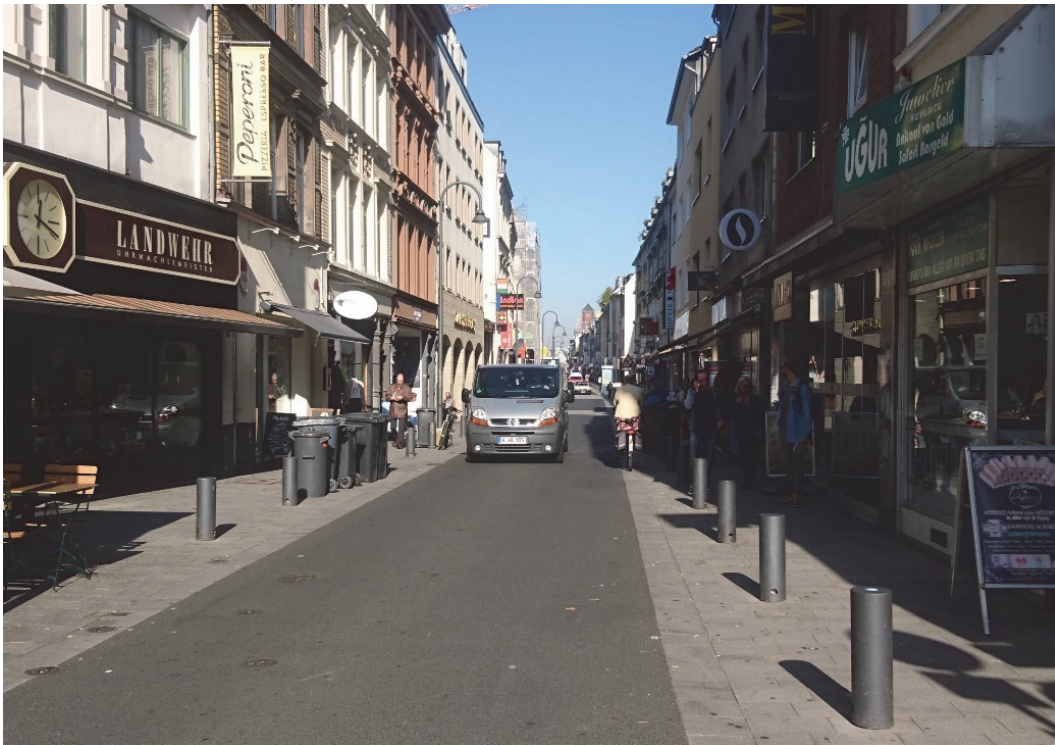
Bild 9 | Fahrbahngestaltung: Die schmale Asphaltfahrbahn mit beidseitigen Muldenrinnen im Material des Seitenraums ermöglicht zwischen den Pollerreihen eine Begegnung von Kfz und Radfahrenden in Gegenrichtung mit ausreichendem Seitenabstand
