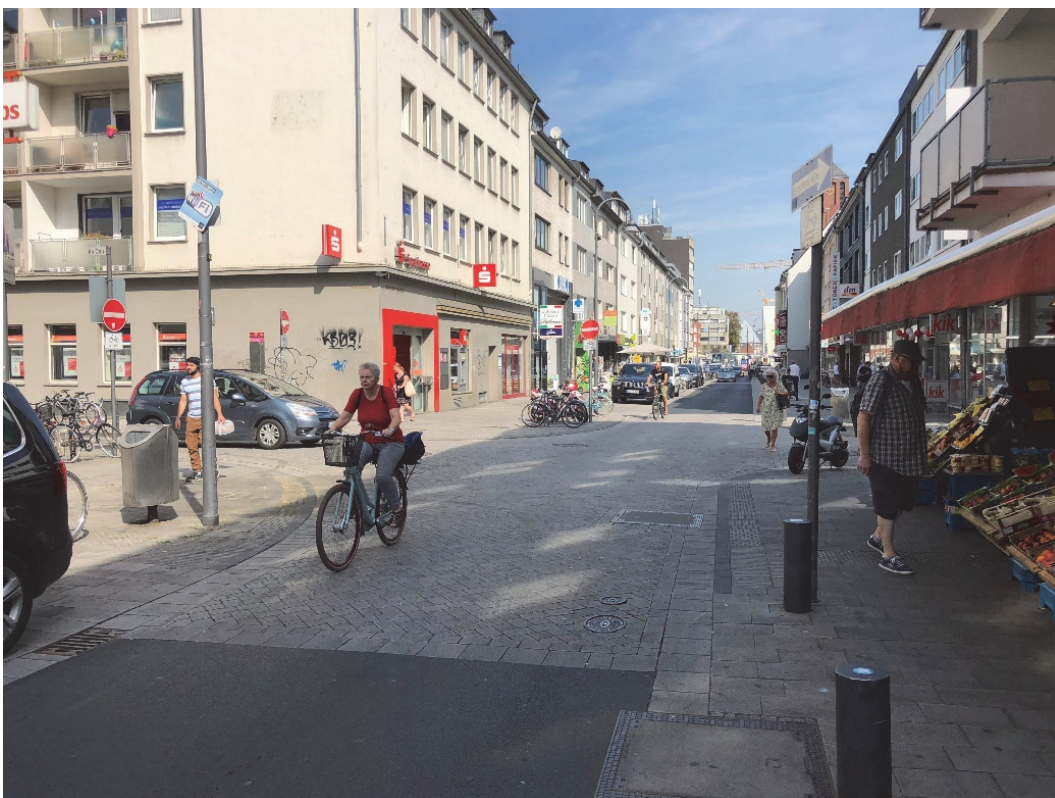
Bild 10 | Knotenpunkte: Betonung durch Materialwechsel, der gegenüber der Asphaltfahrbahn einen deutlichen Unterschied macht und gleichzeitig durch das gewählte Steinmaterial einen deutlichen Bezug zum Seitenraum aufnimmt
