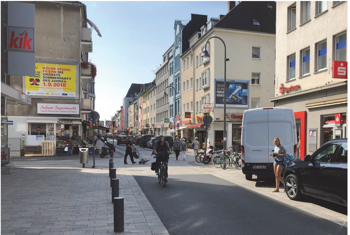
Bild 1 | Die Severinstraße nach der Umgestaltung: Alle Kernfunktionen einer Quartiersgeschäftsstraße – Zufußgehen, freies Überqueren der Fahrbahn, Radverkehr in beiden Richtungen, Parken, Liefern, Außengastronomie – lassen sich bei der gegebenen Querschnittsgestaltung gut miteinander realisieren
