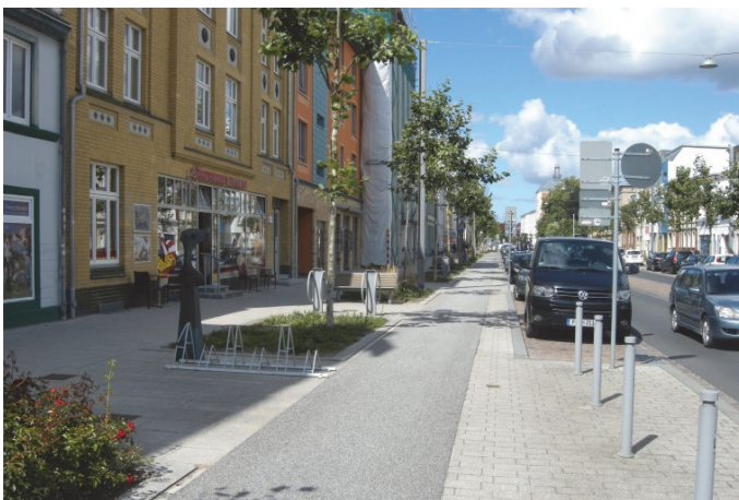
Bilder 13 und 14 | Radverkehrsführung: durchgängige Radwege im Seitenraum mit komfortabel befahrbarer Asphaltoberfläche, Sicherheitsstreifen zu den Parkbuchten und unterschiedlicher Lage im Querschnitt je nach vorhandener Nutzungsstruktur
