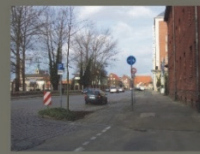
Der überkommene Zustand des Frankendammes wurde seiner Funktion als wichtige Bebauungsfläche und für die Straßen der Altstadt wieder gestufweise nach Funktionalität gewechselt.
