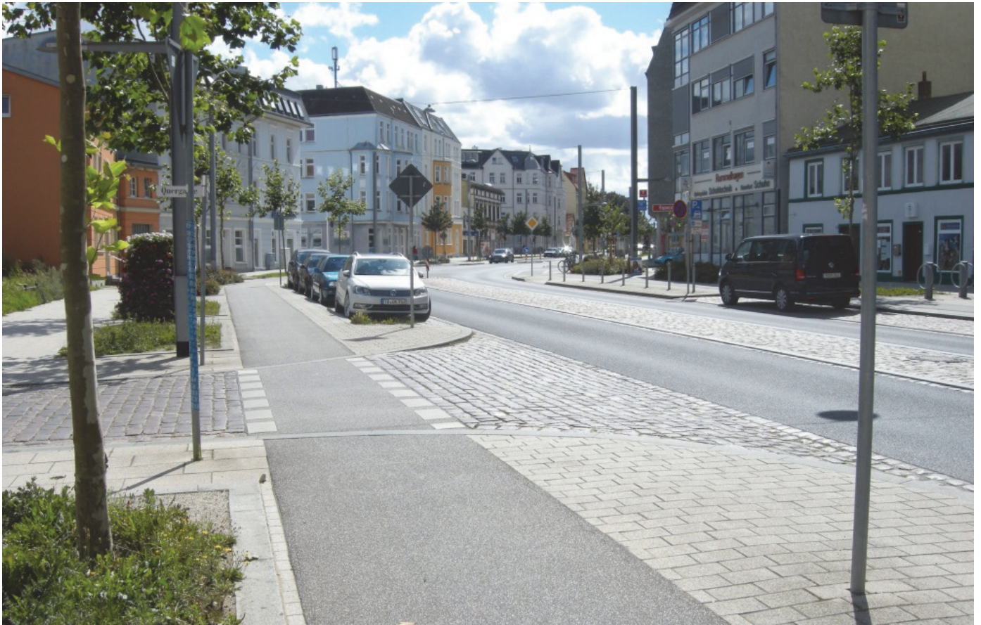
Bild 1 | Der Frankendamm nach dem Umbau: Verbesserte Überquerbarkeit und Aufenthaltsqualität bei funktional und optisch klarer Trennung der Verkehrsarten
