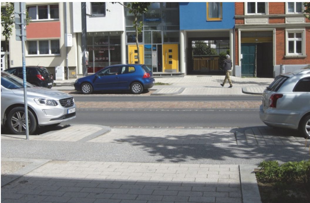
Bilder 21 und 22 | Teilaufpflasterung mit „Radwegüberfahrt“: verkehrssichere und zugleich barrierefreie Gestaltung von Grundstückszufahrten und nachrangigen Einmündungen zugunsten von Zufußgehenden und Radfahrenden
