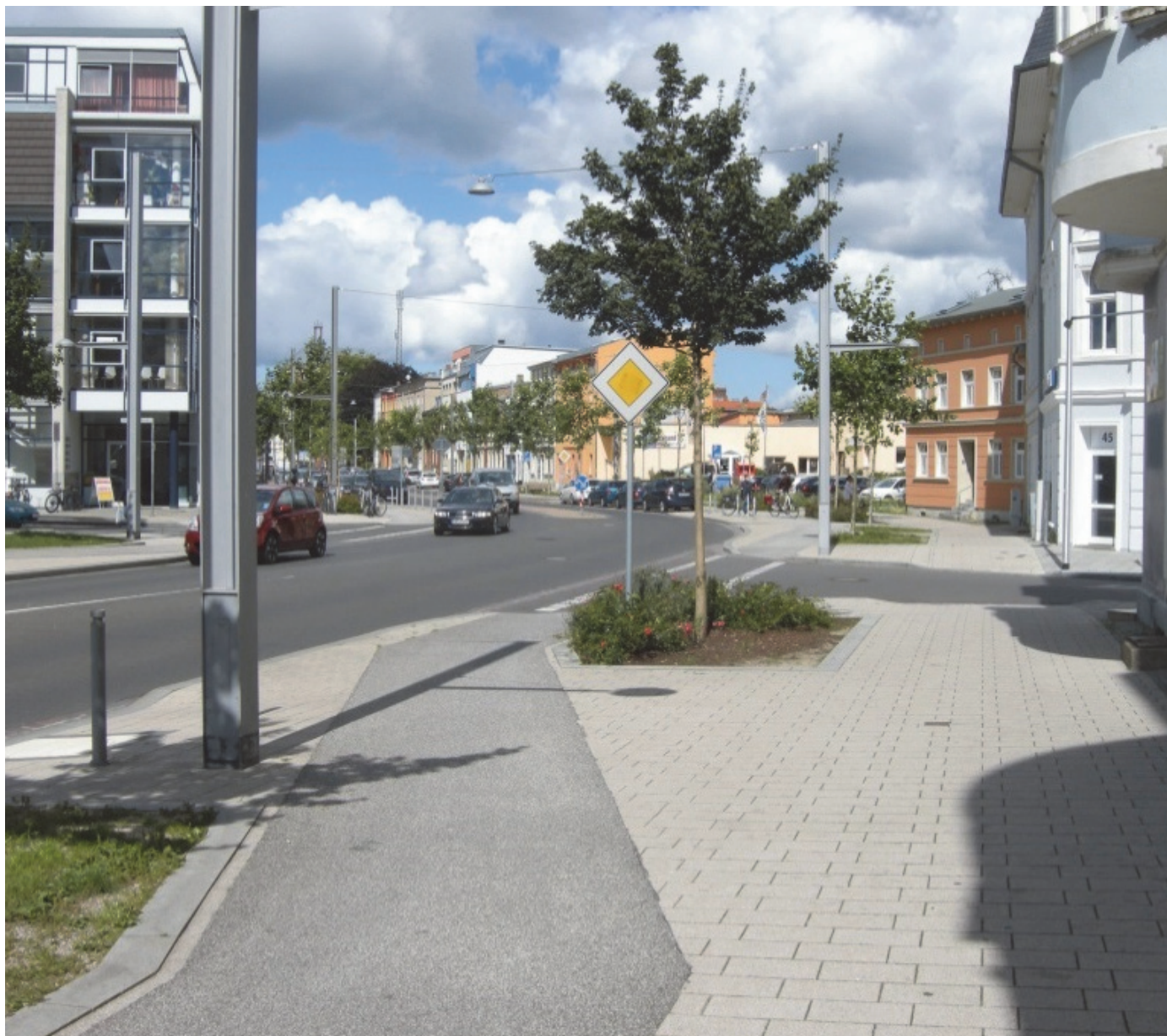
Bild 15 | Wechsel der Radwegführung: Heranführung an die Fahrbahn unmittelbar vor einer einmündenden Seitenstraße mit freigehaltenem Sichtfeld zwischen Kfz-Verkehr und Radfahrenden
