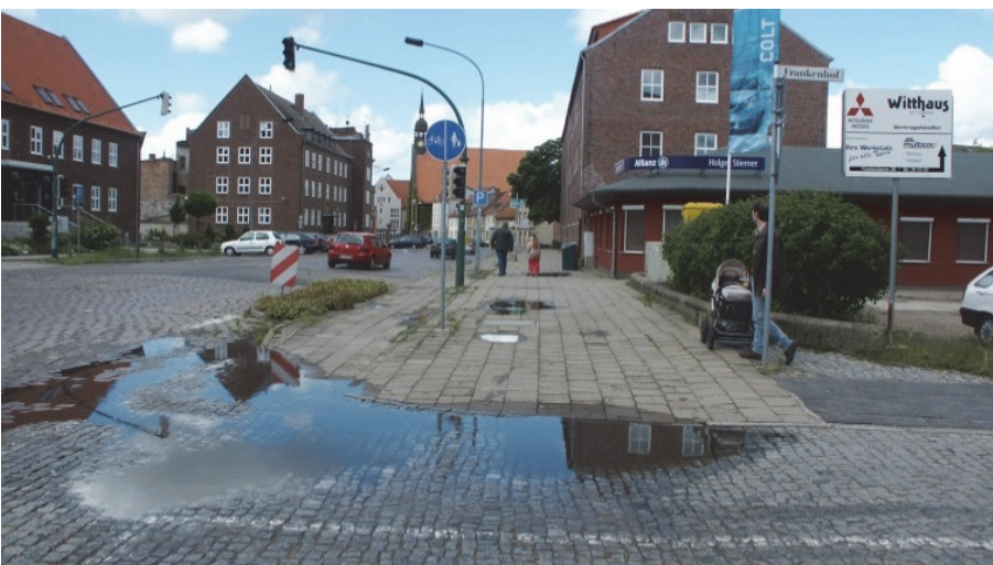
Bilder 3 bis 5 | Vorher-Situation: überdimensionierte Fahrbahn, uneinheitliche Radverkehrsführung, fehlende gesicherte Überquerungsstellen, unattraktiver Seitenraum im zentralen Versorgungsbereich, schlechte Oberflächenbeschaffenheit der Verkehrsanlagen, nach Regenereignissen stehendes Wasser in den Kreuzungsbereichen
