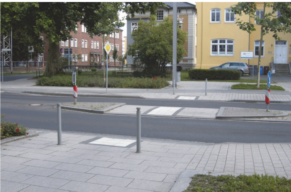
Bild 20 | Bauliche Mittelinsel: punktuelle Sicherung einer barrierefreien Überquerbarkeit des Frankendamms an ausgewählten Stellen mit besonderem Querungsbedarf
