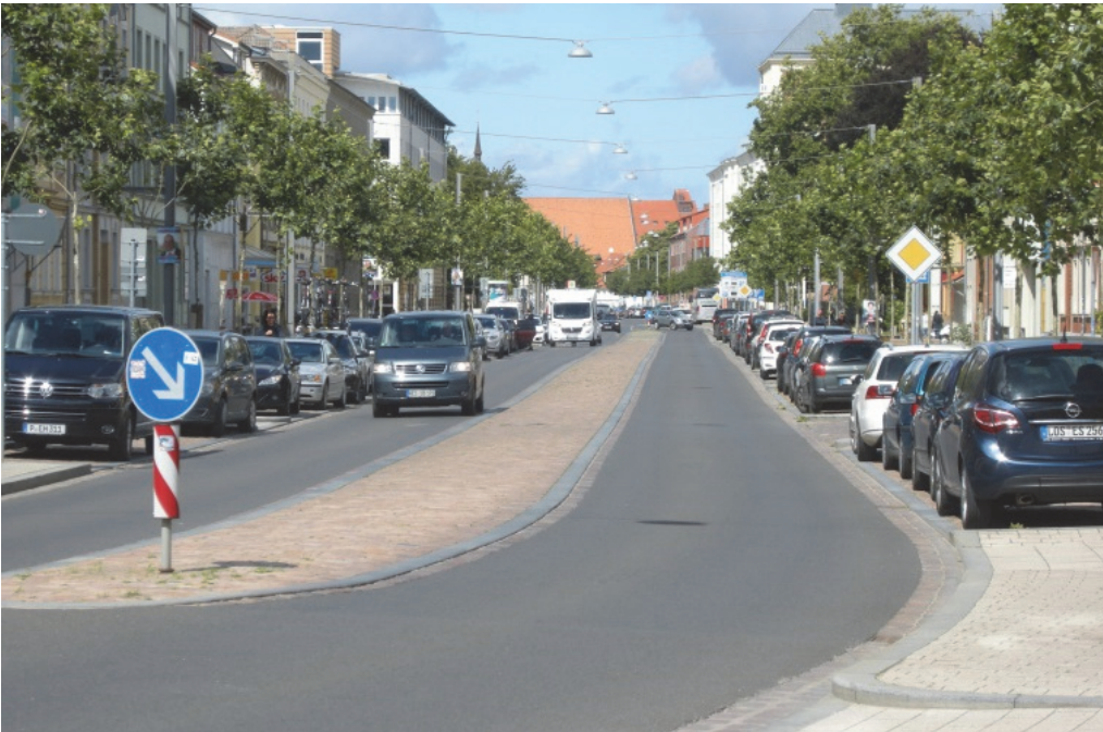
Bild 19 | Überfahrbarer Mittelstreifen im zentralen Versorgungsbereich: lineare Aufpflasterung zur Erleichterung des Überquerens der Fahrbahn, zum störungsfreien Linksabbiegen und zur optischen „Entschleunigung“ des Kfz-Verkehrs
