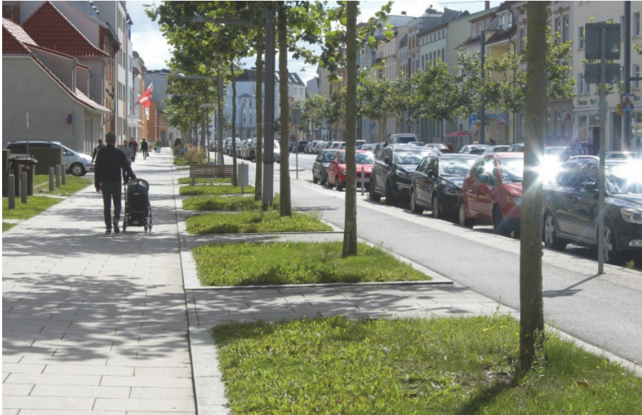
Bild 12 | Gestaltungsprinzip im Querschnitt: Optisch klare Trennung der Flächen für die verschiedenen Verkehrsarten durch unterschiedliche Fahrbahnbeläge, Grünflächen und Parkstände
