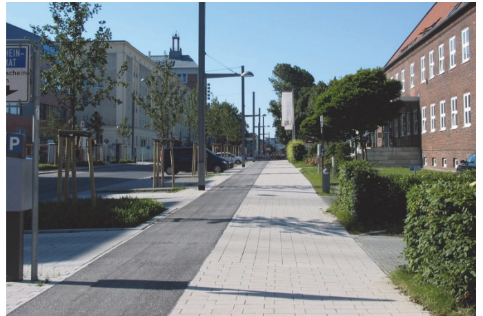
Bilder 13 und 14 | Radverkehrsführung: durchgängige Radwege im Seitenraum mit komfortabel befahrbarer Asphaltoberfläche, Sicherheitsstreifen zu den Parkbuchten und unterschiedlicher Lage im Querschnitt je nach vorhandener Nutzungsstruktur
