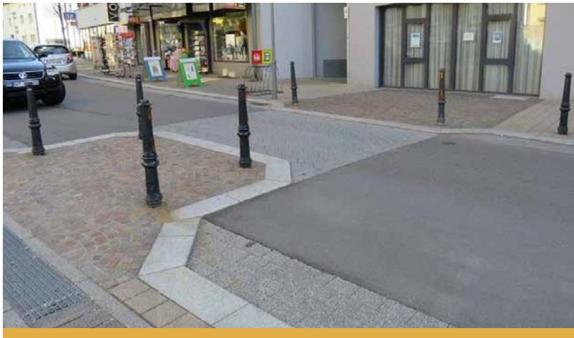
Überquerungsstelle (Schulweg) in heutiger Ausbauf orm in Wehr: nur noch einstreifig befahrbare Engstelle mit Pollern zur Verhinderung des seitlichen Überfahrens Foto: Stadt Wehr
