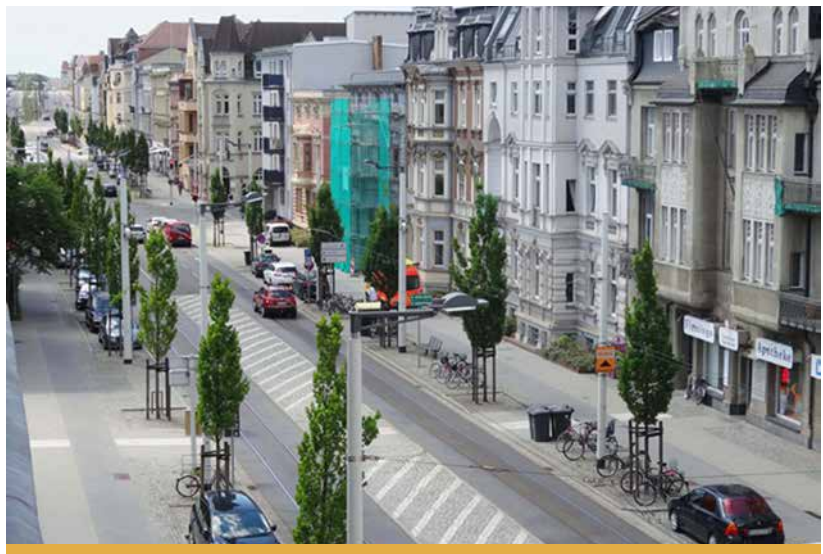
Die Bahnhofstraße in Cottbus nach dem Umbau: differenzierte Querschnittsgestaltung mit dem Ziel der Gleichberechtigung für alle Verkehrsarten Foto: Stadt Cottbus
