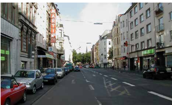
Vorher-Situation der Bonner Straße in Köln: überdimensionierte Fahrbahn mit ungeordneter Nutzung durch den Kfz-Verkehr zulasten des Fuß- und Radverkehrs sowie durch Wegfall der Straßenbahn und Fertigstellung der U-Bahn notwendig gewordene Oberflächensanierung Foto: Stadt Köln
