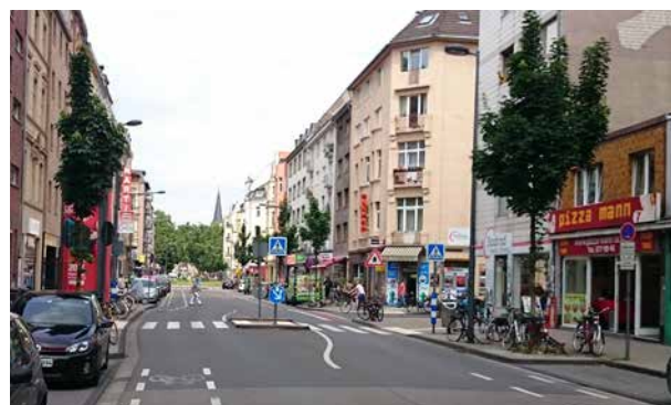
Nachher-Situation: Standard für gesicherte Überquerungsstellen: ausreichend breite Mittelinsel mit beidseitigem Fußgängerüberweg, ergänzt durch Bodenindikatoren für Sehbeeinträchtigte Foto: Prof. Karl Heinz Schäfer, TH Köln
