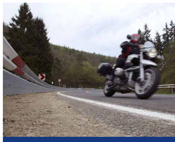
Unterfahrschutz in Kurven erhöht die Sicherheit. Foto: DVR
