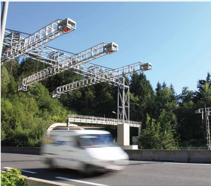
Section Control: Geschwindigkeitsmessung über eine längere Strecke
