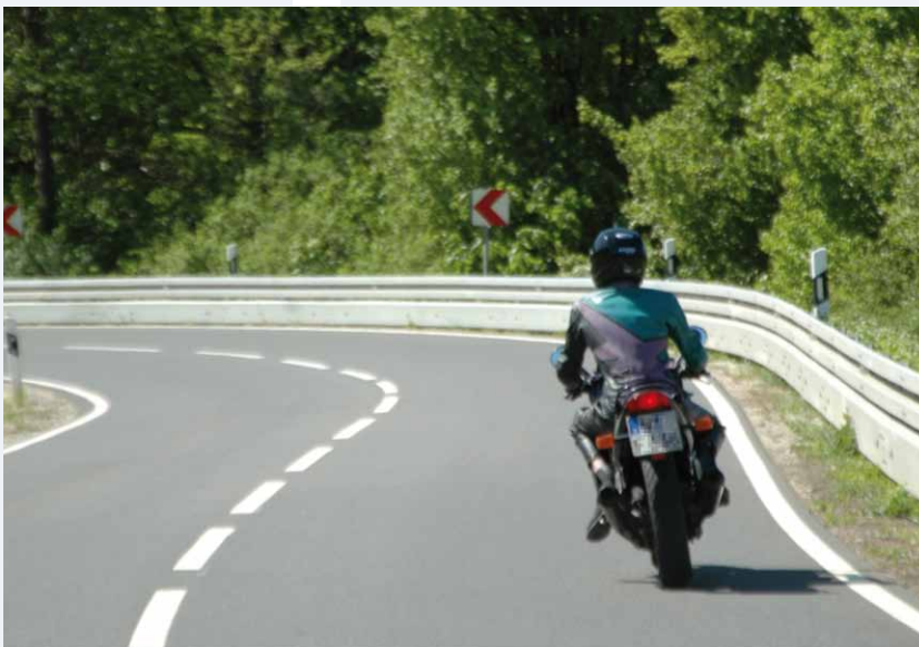
Mehr Sicherheit für Motorradfahrer: Unterfahrschutz an Leitplanken
