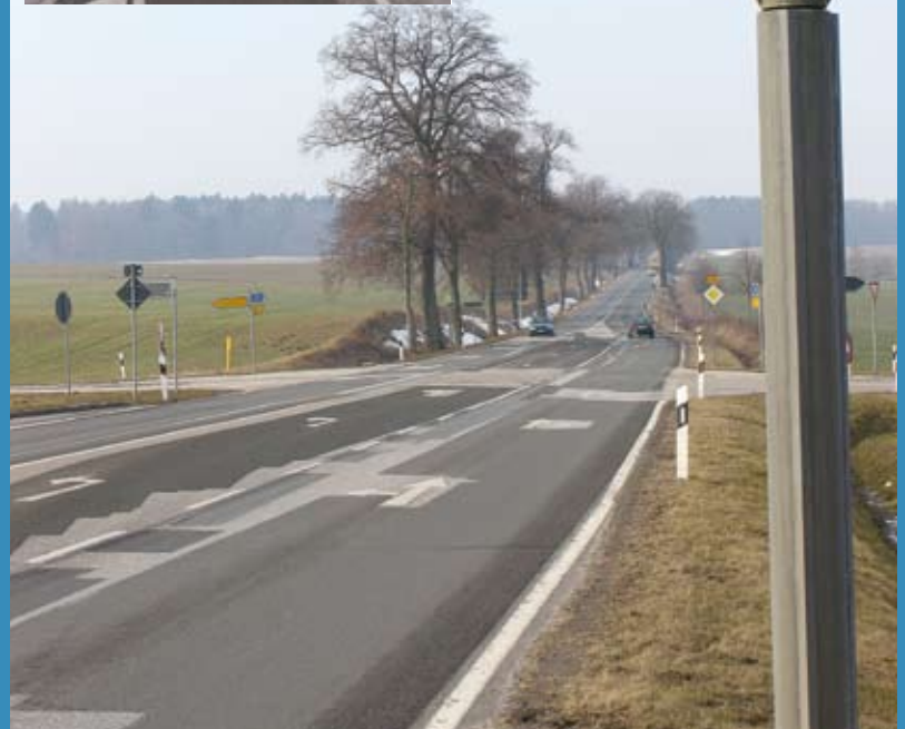
Ausbau einer Kreuzung in Waren (Mecklenburg-Vorpommern) verführte zum schnellen Fahren. Folge: zwei Starenkästen wurden installiert.
