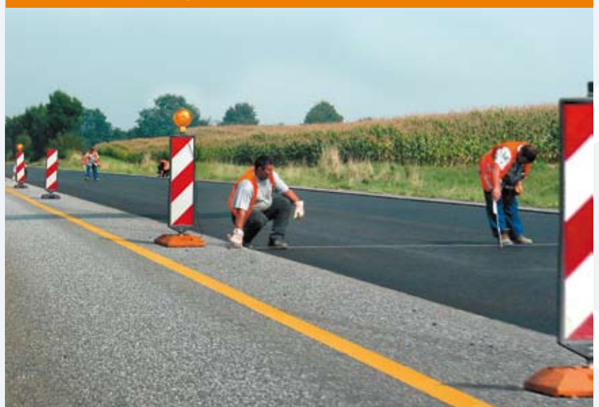
Gefährlicher Arbeitsplatz Baustelle
