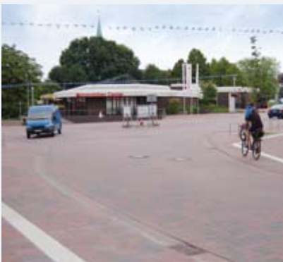
Die Kreuzung Richtung Westen vor dem Umbau und nachher.
