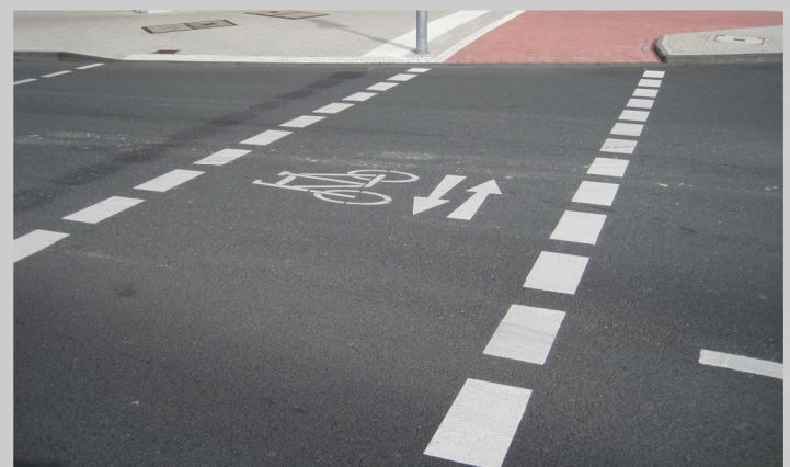
Kennzeichnung Zweirichtungsverkehr auf Furt
