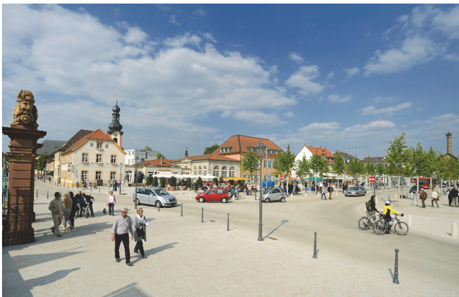
Bild 7 | Integrierte Gestaltung von Fahrbereichen und übriger Platzfläche: einheitliche Gesamterscheinung durch Verzicht auf verkehrstechnische Elemente und angepasste Farbgebung, Nutzung ähnlich dem „Shared Space“-Prinzip
