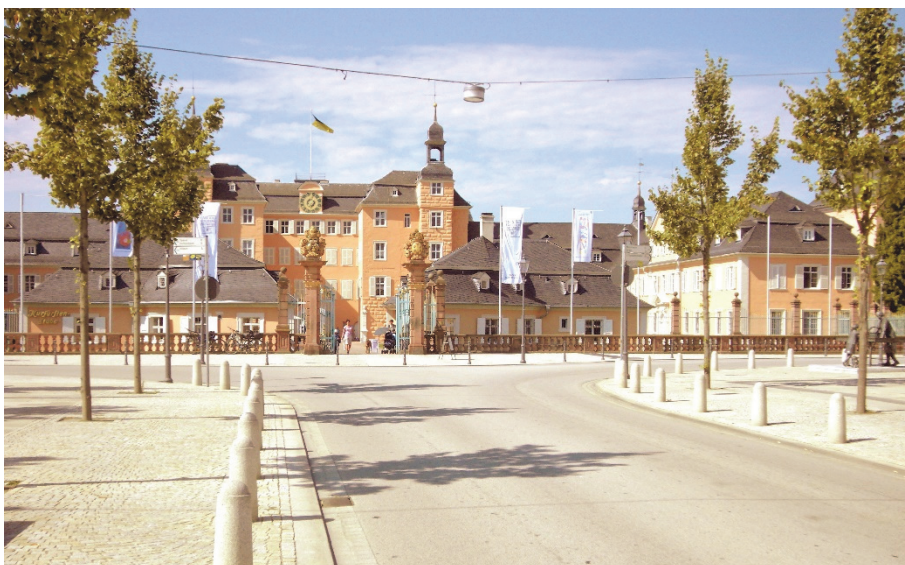
Bild 8 | Übergänge zwischen Fahrbereich und übriger Platzfläche: niedrige Borde in Verbindung mit Pollerreihen schaffen hohe Durchlässigkeit, weitgehende Barrierefreiheit und zugleich eine deutlich wahrnehmbare Führung und Abgrenzung des Fahrverkehrs
