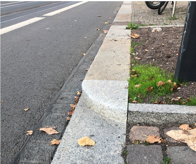
Bilder 48 bis 51 | Oberflächengestaltung und Materialien: Natursteinborde und Flächenbegrenzungslinien aus hellem Granit, Pflasterflächen aus buntem Quarzporphyr mit verschiedenen Steingrößen und weitgehend ungebunden verlegt, im Bereich von Grundstückszufahrten zusätzlich vergossen, um die hohen Fahrzeugbelastungen und Scherkäfte zu bewältigen
