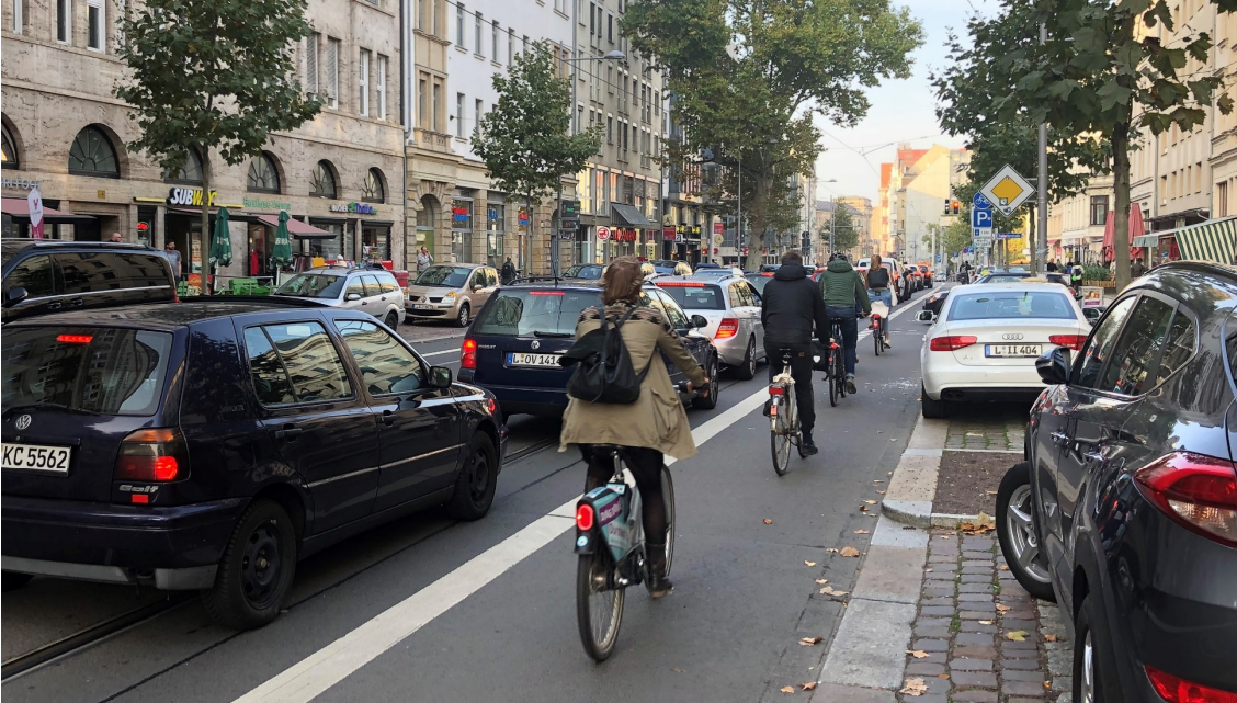
Bild 24 | Radverkehrsführung im Streckenabschnitt: 1,85 m breiter Radfahrstreifen zwischen 3,25 m breitem Fahrstreifen und Hochbord zum Seitenraum, Längsparkstände mit integriertem, 0,75 m breitem Sicherheitstrennstreifen, der von Parkenden jedoch häufig nicht eingehalten wird
