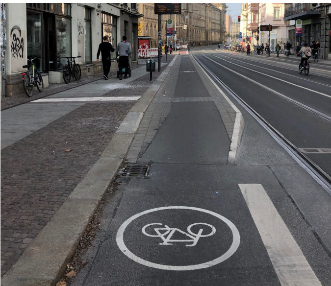
Bilder 25 und 26 | Radverkehrsführung in der Haltestelle „Münzplatz“: abweichend vom Regemaß erfolgt hier eine trichterförmige Verringerung der asphaltierten Fläche für Radfahrende von 1,85 m über 1,50 m am Fuß sowie 1,20 m am Ende der Rampe auf ein 1,00 m breites Asphaltband mit beidseitigem 0,50 m breitem Pflasterstreifen im Zuge des auf Seitenraumniveau angehobenen Streckenabschnitts. Hiermit wird ein Hintereinanderfahren der Radfahrenden erreicht.
