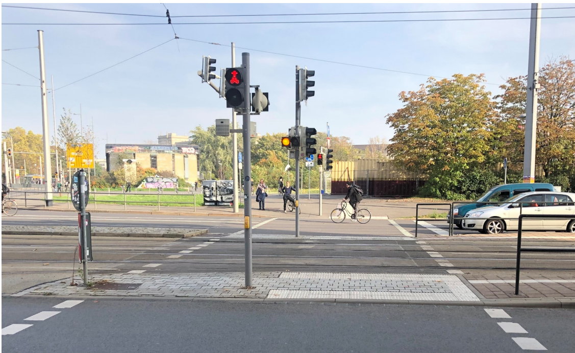
Bild 31 | Signalisierte Furt an der Haltestelle Wilhelm-Leuschner-Platz: barrierefreie Gestaltung mit akustischen und taktilem Elementen sowie Sondersignal mit „Gelb-Blinken“ bei sich annähernder Straßenbahn
