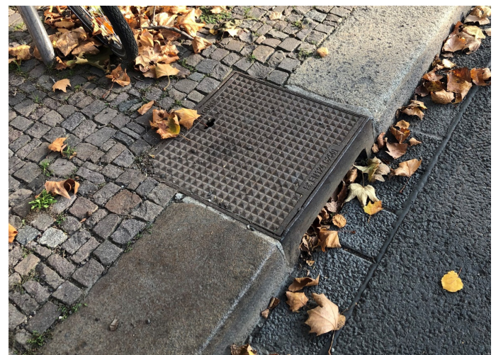
Bilder 52 und 53 | Fahrbahntwässerung: schmale Kastenrinnen und in den Bordstein integrierte Regenwasserabläufe verbessern die Befahrbarkeit des Radfahrstreifens
