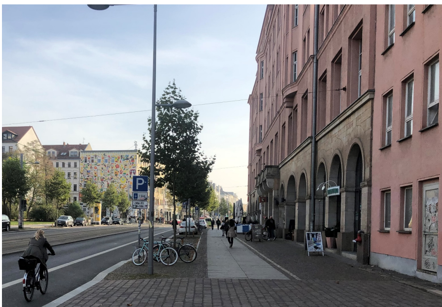
Bild 39 | Grundprinzip der Seitenraumgestaltung: äußerer Multifunktionsstreifen zur Fahrbahn hin (Parken, Liefern, Fahrradabstellen, Baumpflanzungen etc.), Gehbahn und innerer Multifunktionsstreifen zur Bebauung hin (Außengastronomie, Auslagen etc.), Hervorhebung von Grundstückszufahrten durch einheitliche Pflasterung
