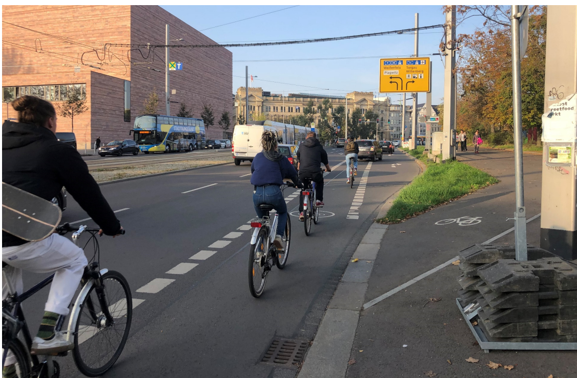
Bild 28 | Radverkehrsführung im Zulauf zum großen Knotenpunkt Peterssteinweg / Martin-Luther-Ring: durchgängig mit Breitstrich markierte Radfahrstreifen in Mittellage (RIM) als „Schleuse“ zwischen den Kfz-Fahrstreifen mit vorherigem Abzweig für Rechtsabbiege in den Seitenraum
