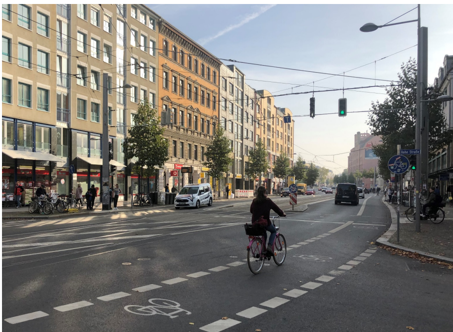
Bild 27 | Radverkehrsführung in Einmündungen: Radfurt mit unterbrochener Breitstrichmarkierung und Fahrradpiktogrammen
