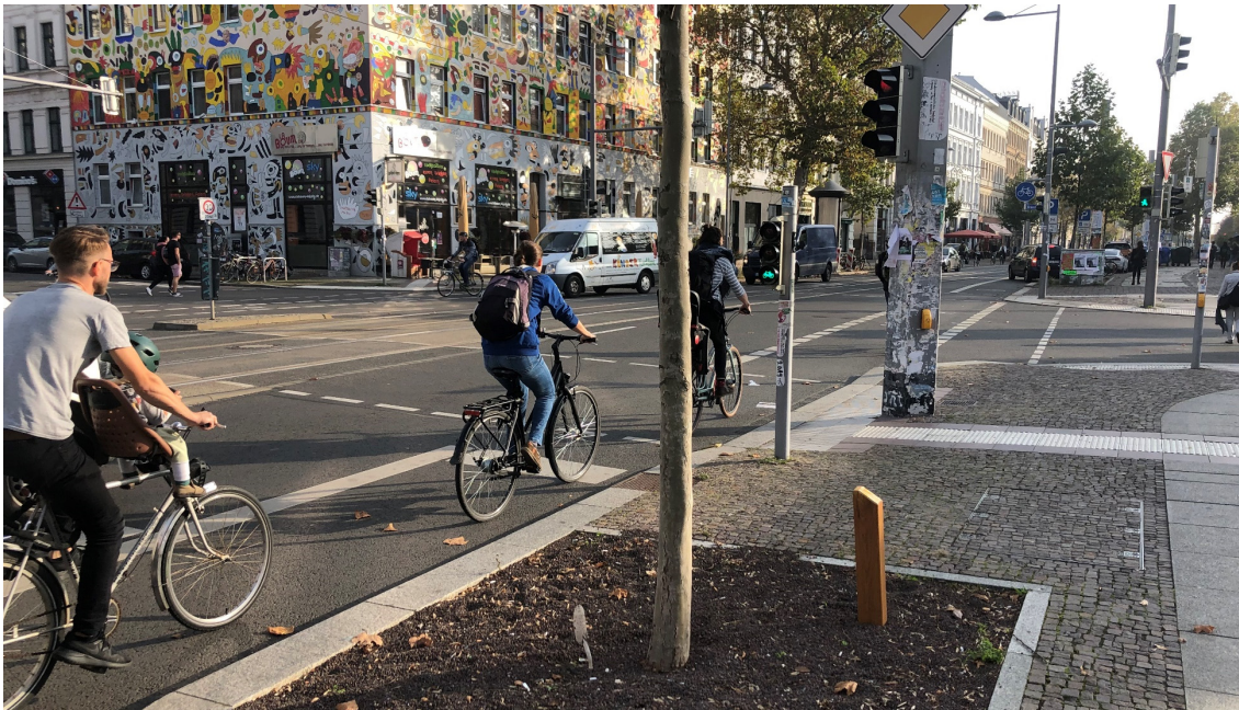
Bild 32 | Knotenpunkt Karl-Liebnecht-Straße / Shakespeare-Straße: umlaufende, signalisierte Furten bieten Zufußgehenden Gehbeziehungen ohne Umwege oder längeres Warten
