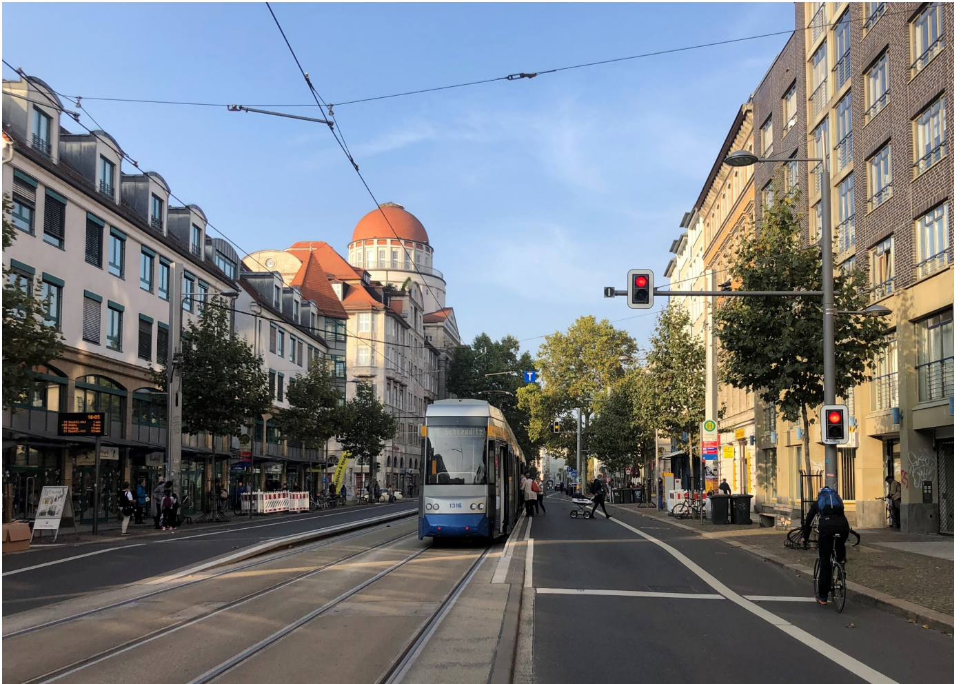
Bild 1 | Straßenzug Peterssteinweg / Karl-Liebkecht-Straße nach der Umgestaltung: auf der innerstädtischen Hauptverkehrsachse südlich des Leipziger Zentrums finden alle Verkehrsarten angemessene Bedingungen und Komfortstandards
