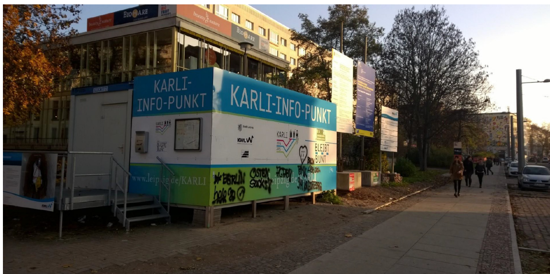
Bild 59 | Anlauf- und Infostelle vor Ort: „KARLI-INFO-PUNKT“ an zentraler Stelle im Planungsgebiet (Ecke Grunerstraße / Karl-Liebknecht-Straße)
