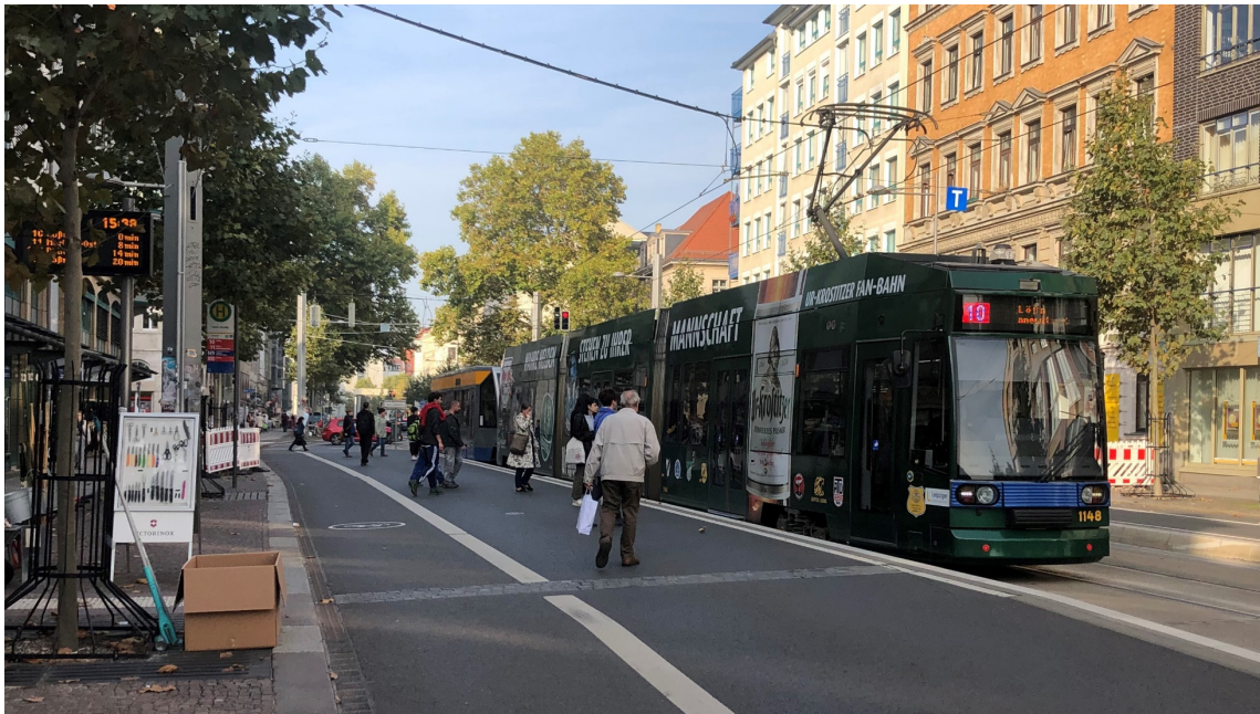
Bild 23 | Haltestelle „Hohe Straße“ unter Betrieb: sicherer, barrierefreier Ein- und Ausstieg bei haltender Straßenbahn über die angehobene Fahrbahn, Wartefläche mit Info-Display und Witterungsschutz im Seitenraum zwischen Gehfläche und Radfahrstreifen
