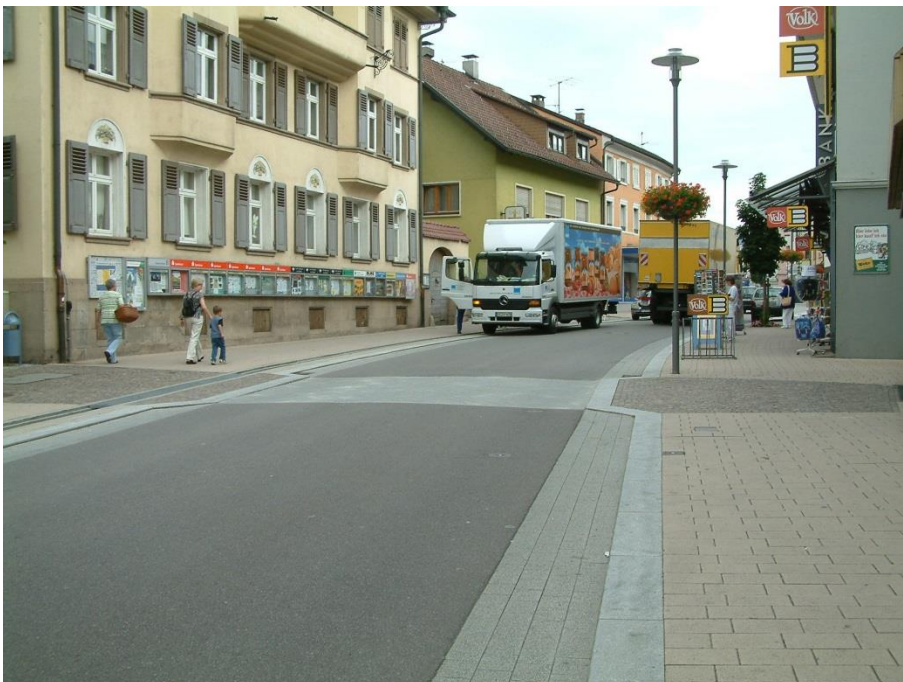
Bild 16 | Überquerungsstelle im Zuge einer quer verlaufenden Fußgängerachse (Schulweg): Einengung mit vorgezogenen Seitenräumen, differenzierter Hell-Dunkel-Farbgebung der Oberflächenmaterialien und direkter Beleuchtung – hier die 2003 realisierte Form
