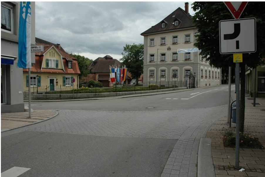
Bilder 9 und 10 | Gestaltung der Eingangsbereiche: abknickende Vorfahrtsregelungen und unterstützende Pflasterflächen in der Fahrbahn sowie Pflasterbänder im Seitenraum betonen die untergeordnete Funktion der Hauptstraße im innerstädtischen Straßennetz
