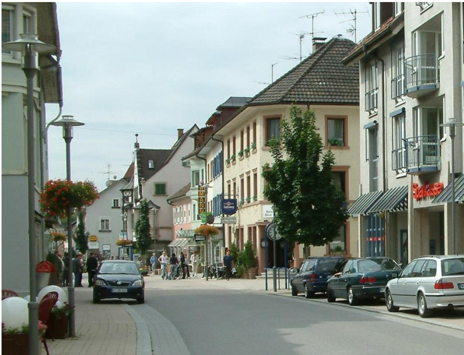
Bild 21 | Kreuzung und Vorplatz am historischen „Storchehus“ von Norden betrachtet: die auf Seitenraumniveau in ähnlichem Material geplasterte Fahrbahn betont die besondere Querungs- und Aufenthaltsfunktion
