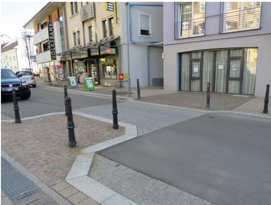
Bilder 17 und 18 | Gleiche Überquerungsstelle in heutiger Ausbauf orm: nur noch einstreifig befahrbare Engstelle mit Pollern zur Verhinderung des seitlichen Überfahrens
