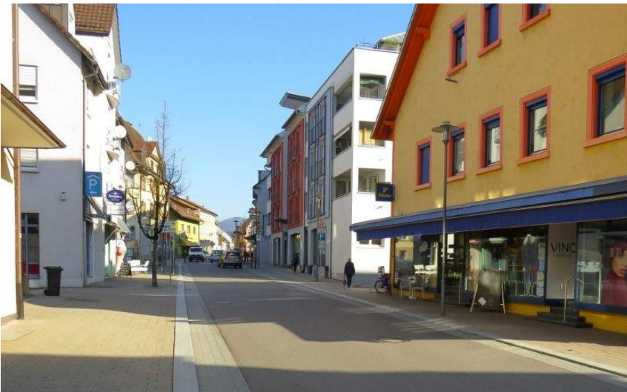
Bild 12 | Gestaltung der Fahrbahn: vierzeilige Bordrinnen und helle Granitbordsteine verschmälern visuell die Fahrbahnbreite, die geringe Bordhöhe bietet durchgängig weitgehende Barrierefreiheit beim Überqueren
