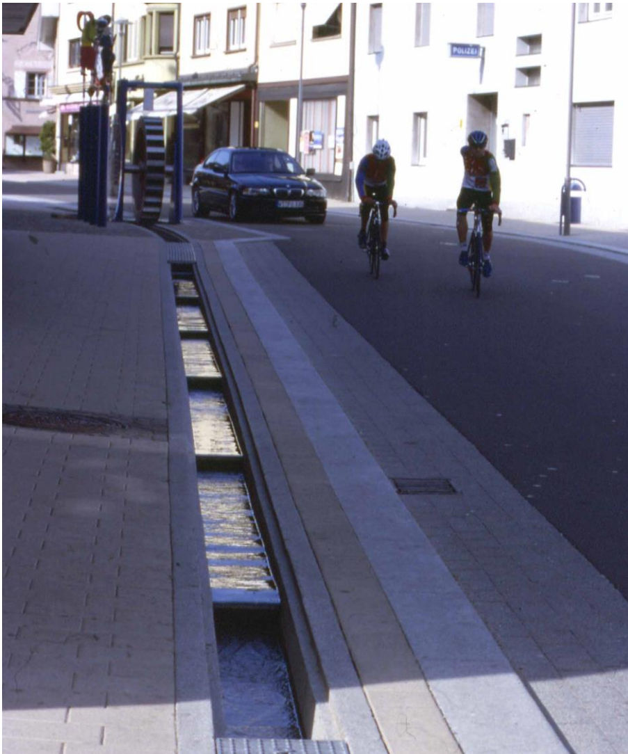
Bild 27 | Gestaltungselement „Bächle“: offenes Gerinne zwischen den Wasserspielen, in einem hochwertigen Beton-Formstein gefasst
