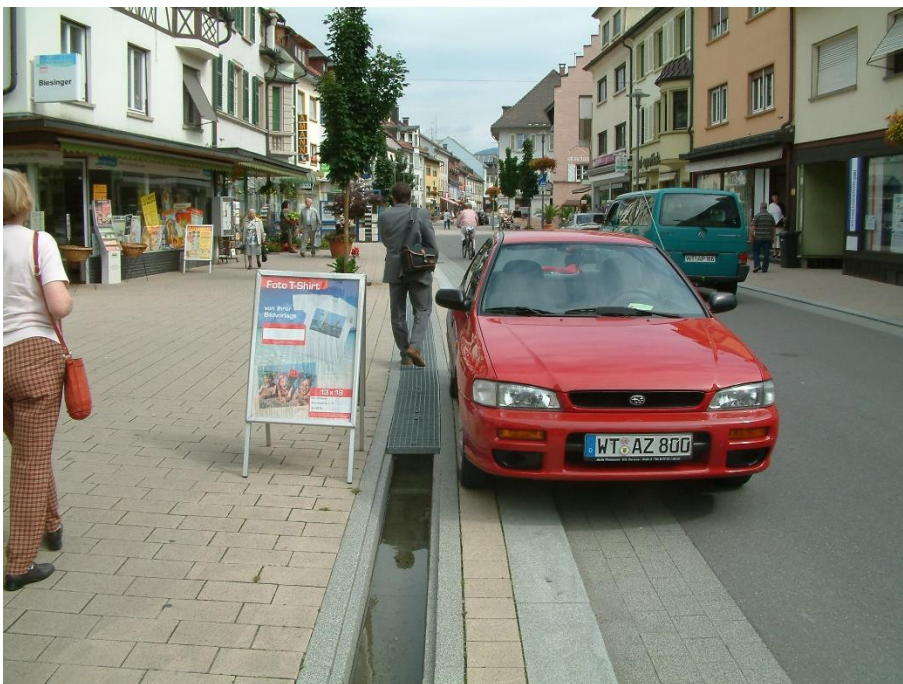
Bild 28 | Gestaltungselement „Bächle“: übergeh- und überfahrbare Gitterroste im Bereich von Grundstückszufahrten und notwendigen fußläufigen Übergängen
