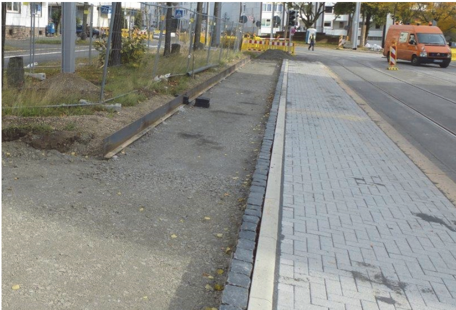
Bild 42 | Recycling vorhandener Natursteinmaterialien: Granitschwellen und Basaltpflaster finden in Bordanlagen, Parkflächen und Einfassungen Wiederverwendung.
