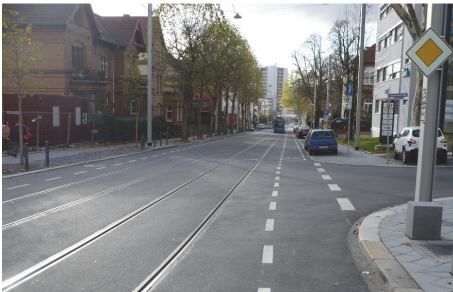
Bild 29 | Radfahren auf der Germaniastraße: Abweichend von der ursprünglichen Planung wurde im Zuge der Markierungsarbeiten noch ein schmaler Sicherheitsstreifen zu den Längsparkständen realisiert. Der Schutzstreifen weist dementsprechend nur noch ein Mindestmaß auf.
