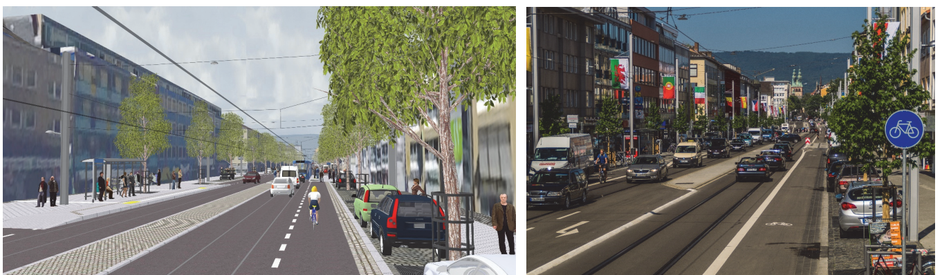
Bilder 51 und 52 | Realisierung eines vergleichbaren Gestaltungsprinzips: Die später umgestaltete Friedrich-Ebert-Straße weist eine vergleichbare Querschnittsgestaltung auf mit integrierter Führung von Straßenbahn und Kfz-Verkehr auf gleicher Fahrbahn wie auch eine gleiche Gestaltung der Straßenbahnhaltestellen mit angehobener Radverkehrsführung im Bereich der Kaps – links die Visualisierung im Zuge des Planungsprozesses, rechts die fertiggestellte Straße.
