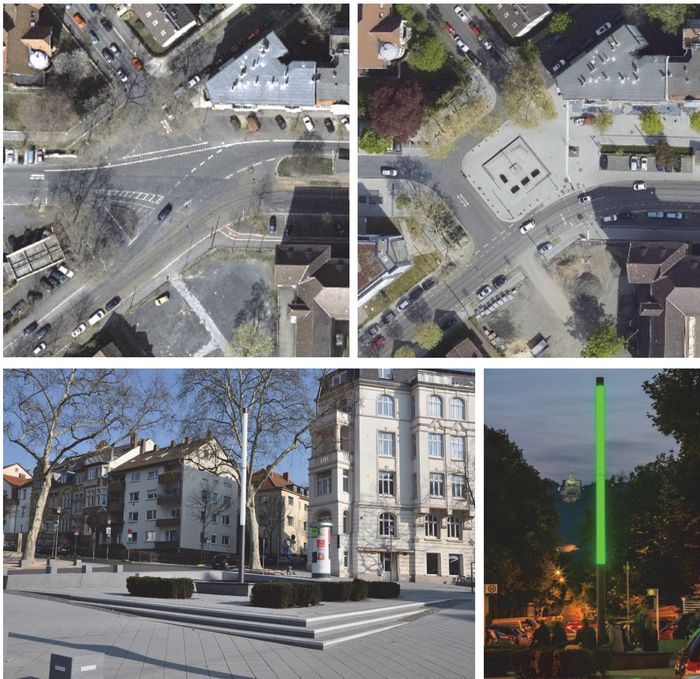
Bilder 38 bis 41 | Rudolphsplatz vor und nach dem Umbau: Aus der überdimensionierten Verkehrsfläche (links oben) entsteht durch Neuordnung der Verkehrsfläche und Rückbau auf das funktional Notwendige ein rd. 1.800 m 2 großer, repräsentativer Seitenplatz. Die Lichtstele setzt die Sichtachse zum Herkules-Denkmal auch nachts gekonnt in Szene (rechts unten).
