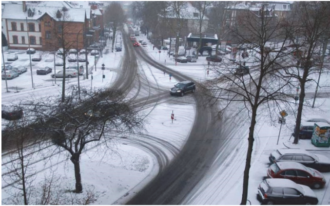
Bilder 9 und 10 | Vorher-Situation: Die Knotenpunkte weisen aufgrund überdimensionierter Verkehrsflächen für alle am Verkehr Teilnehmenden unübersichtliche Situationen auf, was durch die sichtbar werdenden Fahrspuren im Winter besonders anschaulich wird.
