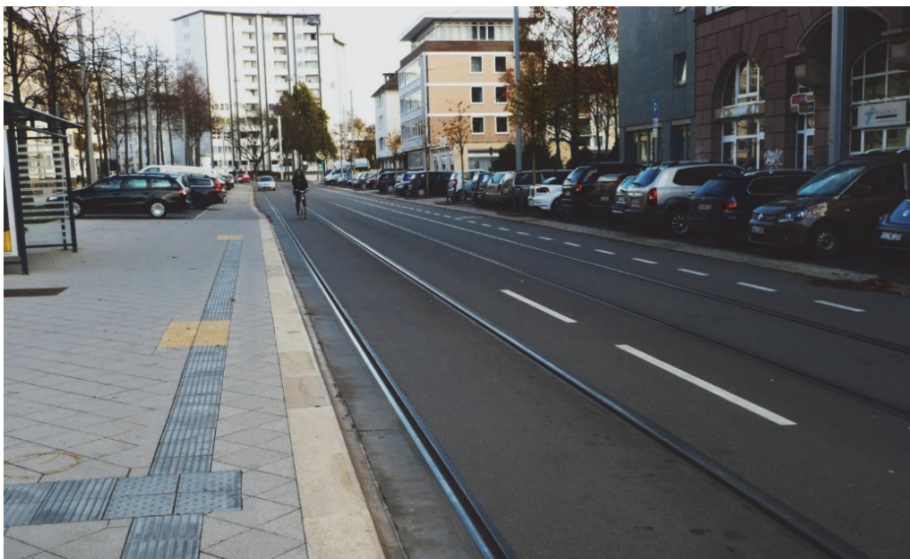
Bild 23 | Barrierefreier Ausbau der Straßenbahnhaltestelle, hier auf der Promenadenseite: Der Abstand zur äußeren Schiene beträgt im Bereich der Haltestelle maximal 0,23 m, der Einstieg in die 30 m langen Niederflurfahrzeuge ist niveaugleich.
