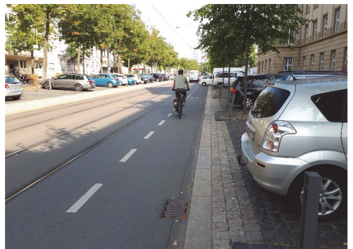
Bilder 19 bis 21 | Senkrechtparkstände in Kombination mit straßenbündigen Straßenbahngleisen: Zunächst im Laborversuch (Bild links) erfolgreich getestet, stellt ein breiter Sicherheitsstreifen auf der Nordseite (Bild links unten) rund 2,60 m Abstand zum äußere Schiene her und verbessert dadurch die Sichtverhältnisse. Auf der Südseite stellen Schutzstreifen und neben liegender Sicherheitsstreifen (Bild rechts unten) einen vergleichbaren Abstand her.
