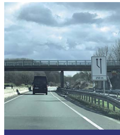
Straßenbaulich wird einiges umgesetzt, um das Überholen sicherer zu machen.
