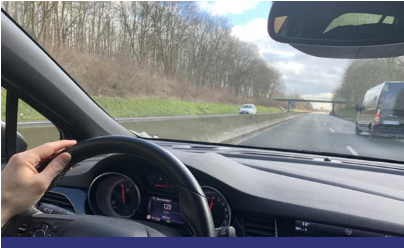
Eine bauliche Trennung der beiden Fahrrichtungen wird beim vierstreifigen Ausbau von Bundesstraßen genutzt, um Unfälle zu verhindern.
