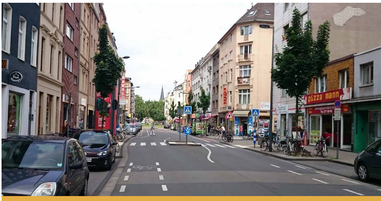
Bonner Straße in Köln: Beispiel für eine gesicherte Überquerungsstelle mit ausreichend breiter Mittelinsel und beidseitigem Fußgängerüberweg, ergänzt durch Bodenindikatoren für Sehbeeinträchtigte. Foto: Prof. Karl Heinz Schäfer, TH Köln
