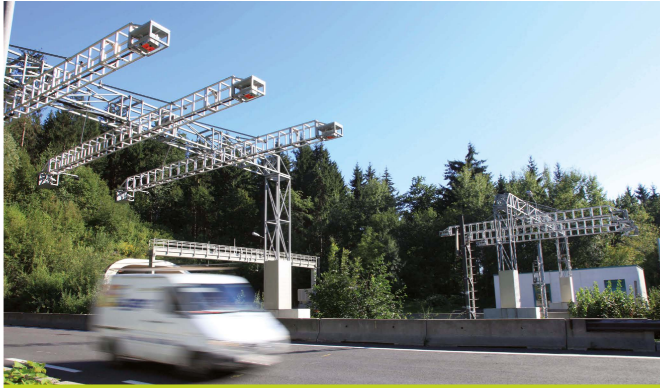
Bei der Abschnittskontrolle wird die Durchschnittsgeschwindigkeit auf einer Strecke über mehrere Kilometer gemessen. Foto: Helmuth Weichselbraun
